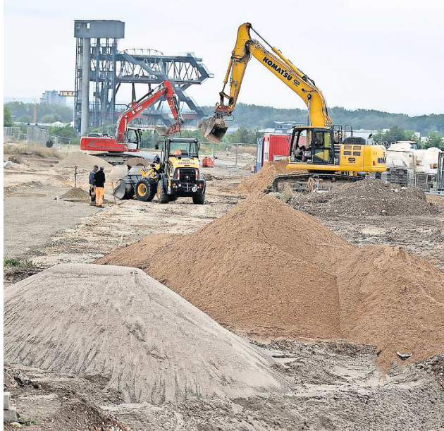
Die Erschließung der Neubaugrundstücke ist in vollem Gange. Das Quartier wächst vor der Kulisse des niederländischen Expo-Pavillons. FOTO: RAINER DRÖSE
