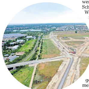
Das Neubaugebiet mit der Baustraße. FOTO: PRIVAT
