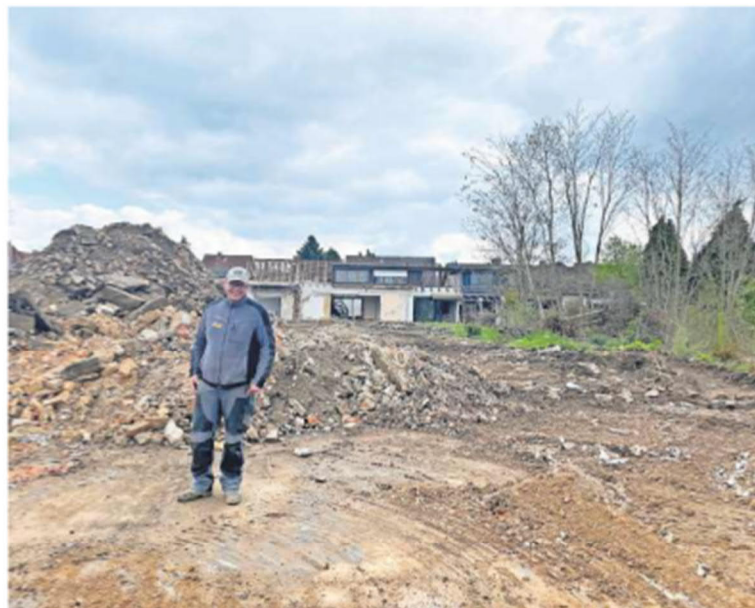
Andreas Fries ist derzeit noch dabei, das Gelände für den Neubau zu ebnen. Der Bebauungsplan für das Areal könnte zum Ende des Jahres geändert sein – davon geht die Firma Gundlach aus.
